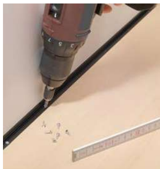
4. Закрепить шурупами (Шурупы с потайной головкой 2,5x10)
